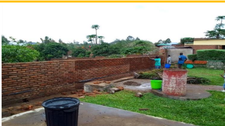
Schade herstellen na de storm
